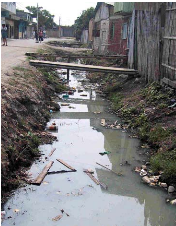
Open canals for wastewater in Guasmo. Photo courtesy Observatorio Ciudadano de Servicios Públicos.
